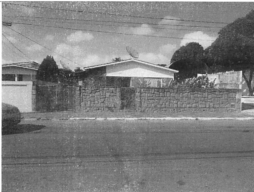
Vista frontal do imóvel, com muro formado por pedras do tipo Rachão, portões com contornos em ferro galvanizado e corpo em chapas de madeira. A largura frontal do terreno do imóvel é de 15,14 metros.
