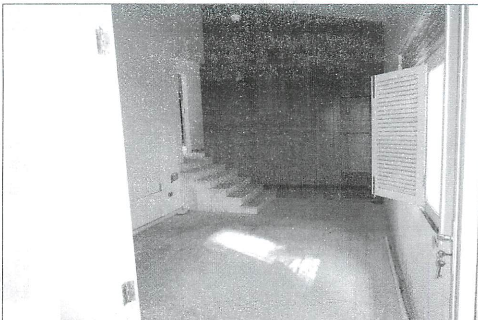
Sala 04: vista geral do compartimento, com escada de acesso, parede com revestimento em folheto de madeira (3,76 x 4,23), janela (2,60 x 1,40) e porta de acesso para a Cozinha (1,00 x 2,10). Dimensões: 5,60 x 3,76 x 4,23 (altura).
