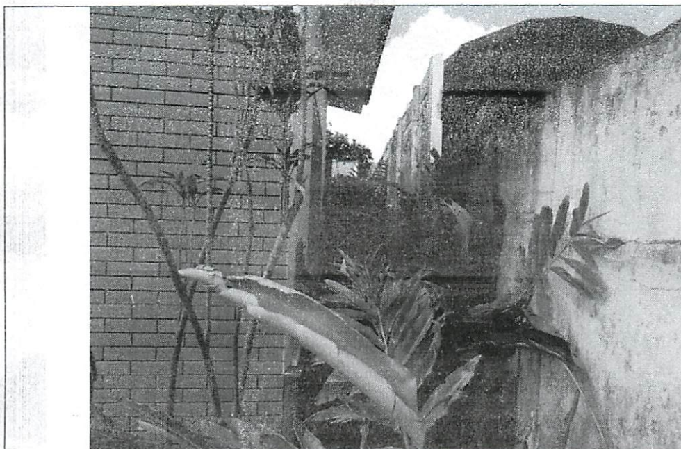
Corredor externo lateral: visão geral: Dimensões: 26,87 x 4,17 metros.
