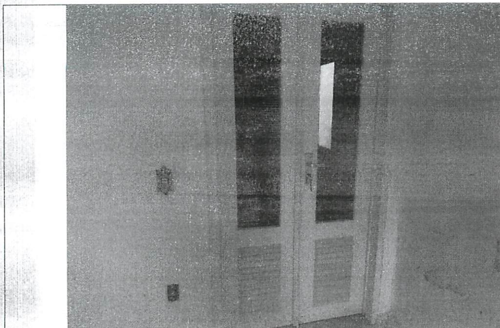
Porta de acesso da Sala 2 para a Sala 4. Dimensões: 1,00 x 2,10 metros.
