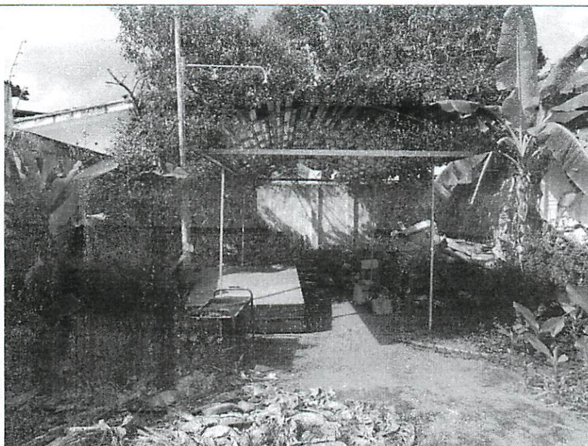
Visão de cobertura em alumínio: demolição.
