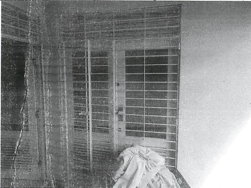
Esquadrias: porta de entrada (terraço) para a Sala 1 com grade. Dimensões: 1,99 x 1,56 metros.
