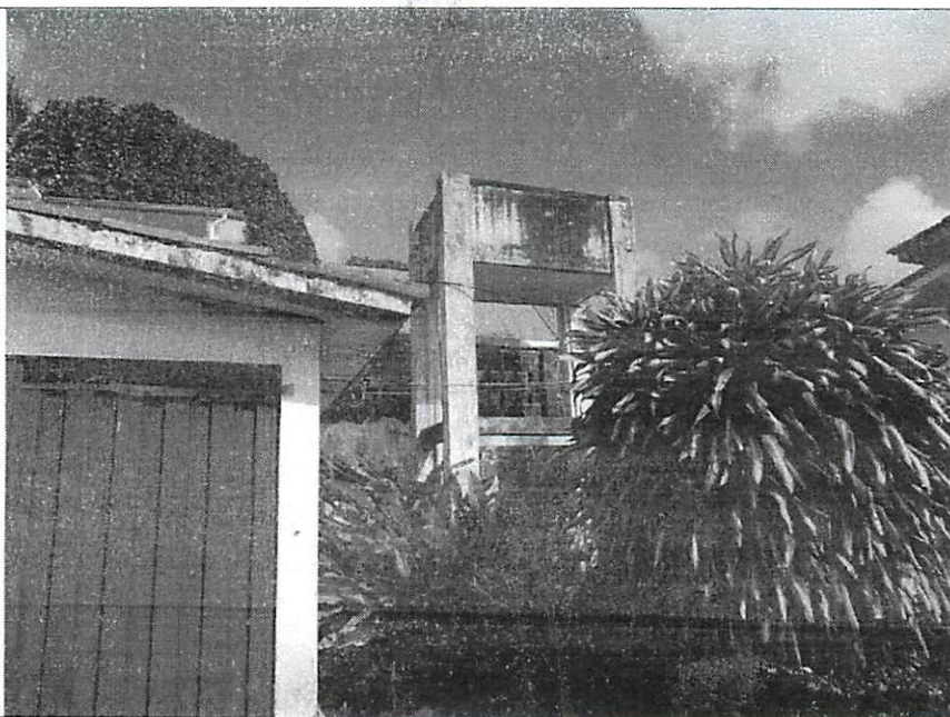
Caixa d'água: visão geral.
