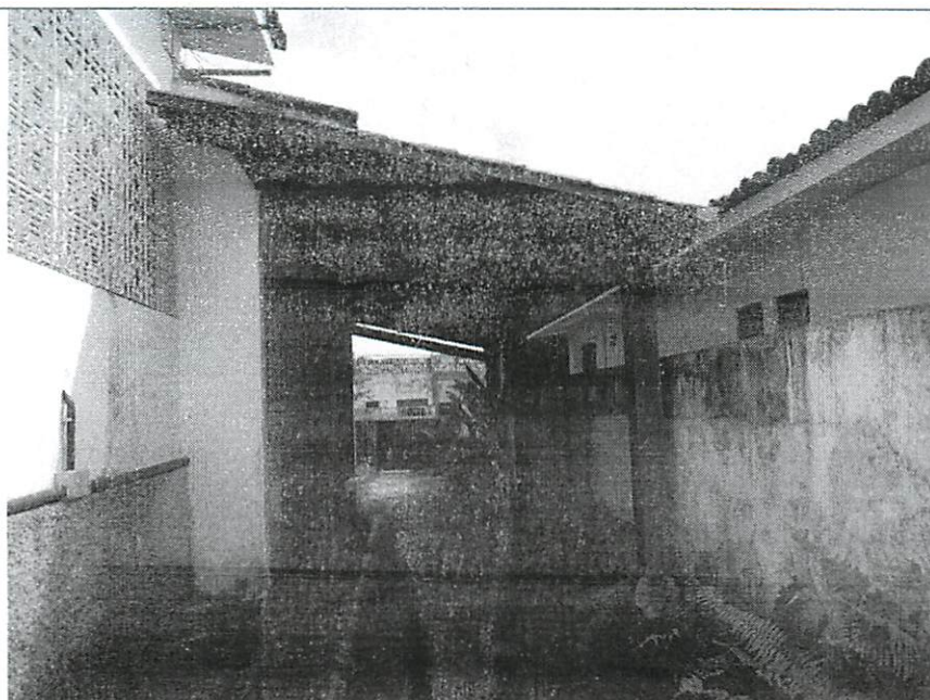
Cobertura de telhas: visão geral.
