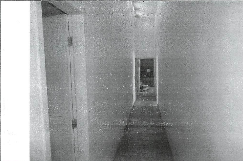
Corredor: visão geral do compartimento, com porta de acesso vindo da Sala 04 (2,10 x 1,00), por fora revestida em folheto de madeira e por dentro pintada com tinta esmalte.
