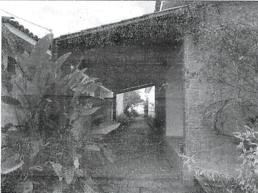
Visão da cobertura com colunas de sustentação, cámbrios e ripas em madeira de qualidade, e telhas de cerâmica do tipo colonial. Dimensões: 8,20 x 2,80 x 3,40 (altura).
