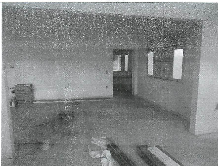
Sala 02: vista geral do compartimento, com porta de acesso para a Sala 04 (2,10 x 1,00 m) e janela (2,60 x 1,40 m). Dimensões: 5,36 x 4,00 x 4,30 (altura).
