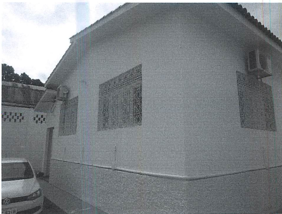
IMAGEN: 11 - ÁREA EXTERNA COM EQUIPAMENTO PRÉ INSTALADO
