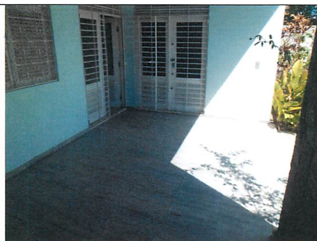
Foto 5 – Vista do Terraço
