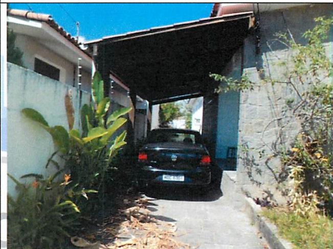
Foto 4 – Detalhe da garagem da unidade avalianda
