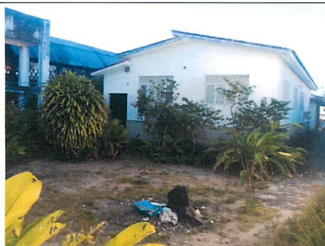
Foto 3 – Vista dos fundos da unidade avalianda
