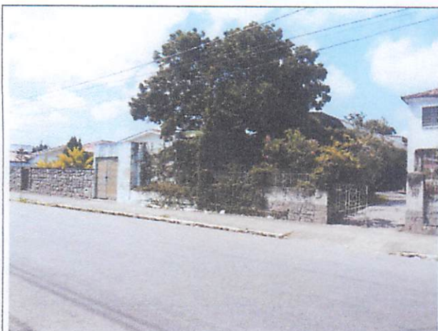
Foto 1 – Vista frontal do imóvel pela Rua Deputado Barreto Sobrinho
