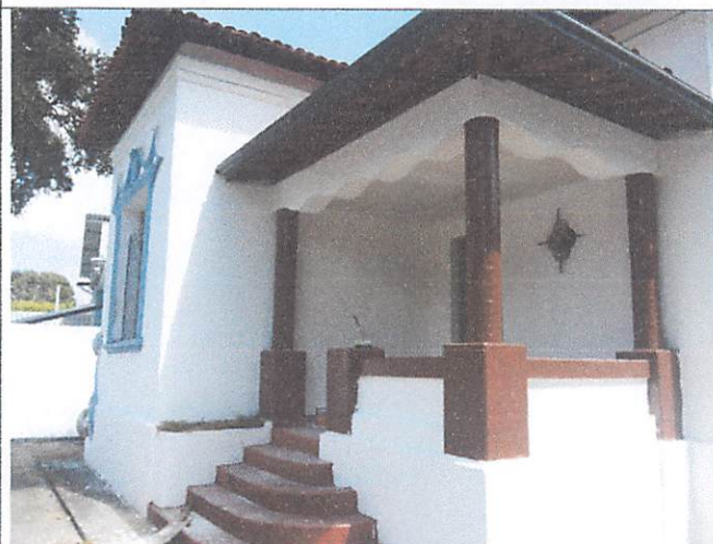
Foto 3 – Vista da frente do imóvel pela Rua Walfredo Leal
