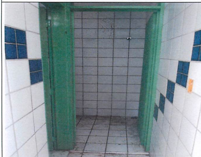
Foto 17 – Vista interna dos banheiros da edificação 03
