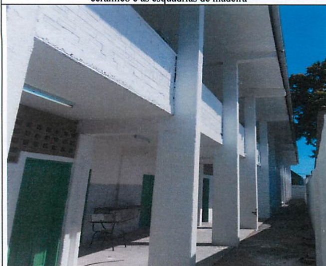
Foto 9 – Vista da Edificação 02, com o revestimento da cerâmica aparente com sua pintura e a estrutura de concreto.
