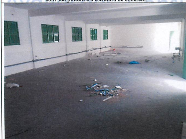
Foto 11 – Detalhe de uma das salas da edificação 02.
