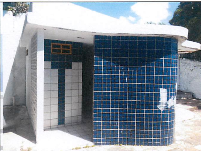
Foto 16 – Vista externa dos banheiros que compõem a edificação 03.
