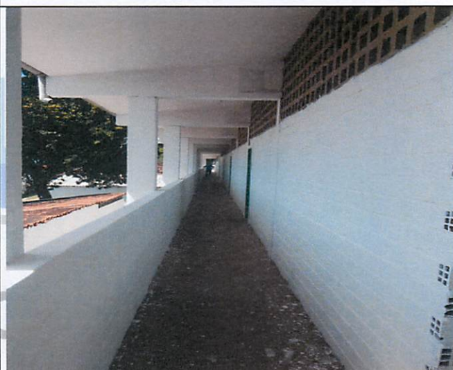
Foto 10 – Detalhe da circulação superior da Edificação 02.
