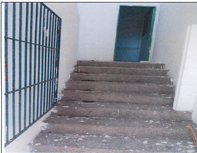
Foto 13 – Vista da escada da Edificação 02.
