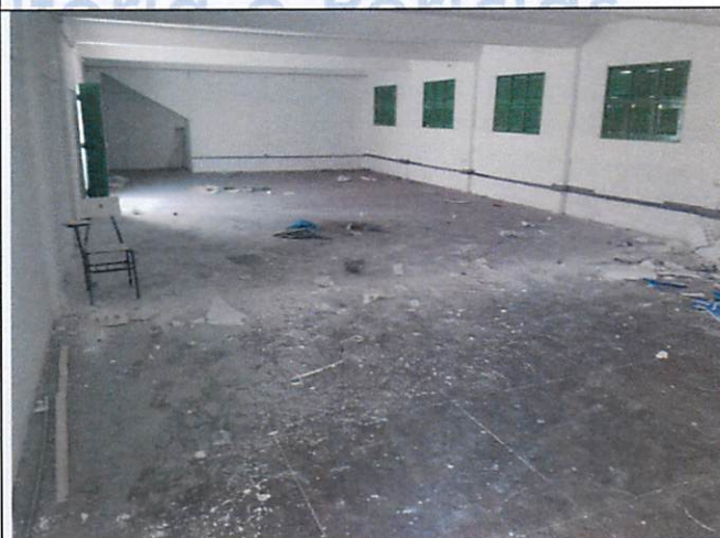
Foto 12- Vista de uma das salas da Edificação 02, com o piso em granilite e as esquadrias de madeira.
