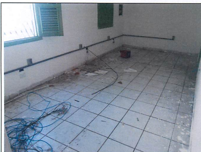
Foto 7 – Vista de uma das salas da Edificação 01, tendo no detalhe o piso cerâmico e as esquadrias de madeira
