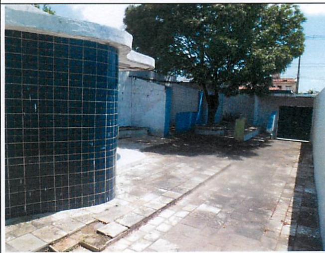
Foto 18 – Vista do patio externo que dá acesso a edificação 03.
