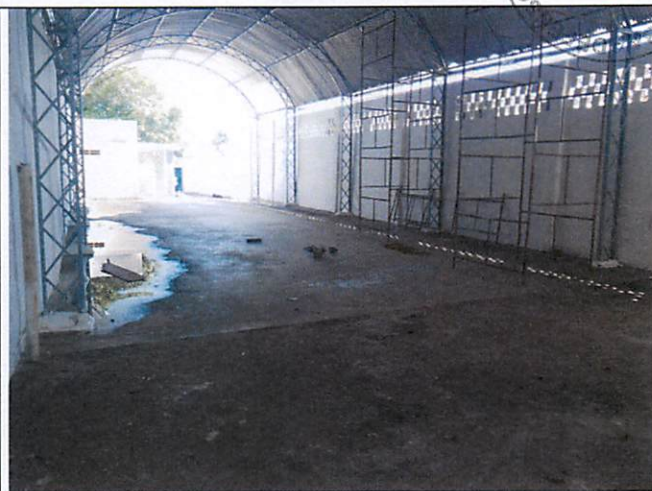
Foto 14 – Vista interna da edificação 03 – Quadra poliesportiva.
