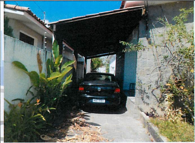
Foto 4 – Detalhe da garagem da unidade avalianda
