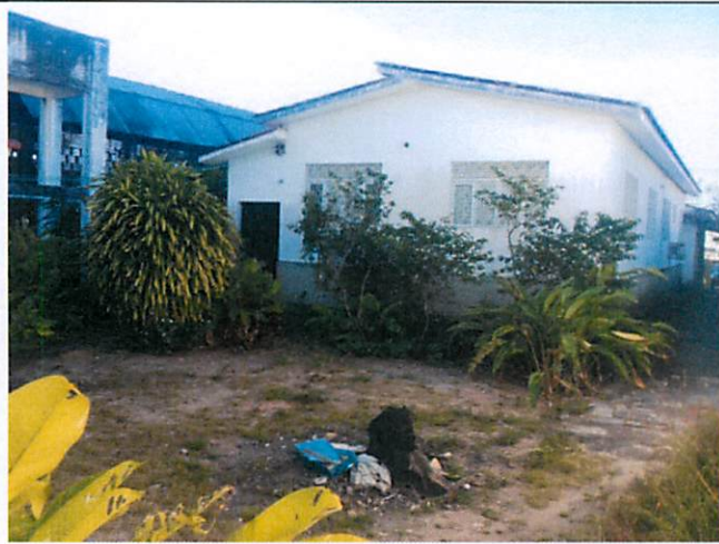
Foto 3 – Vista dos fundos da unidade avalianda
