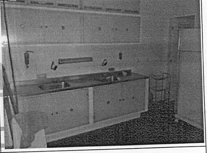
Foto 10 – Detalhe da cozinha
