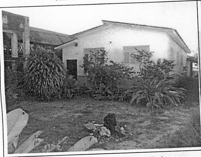
Foto 3 - Vista dos fundos da unidade avalianda
